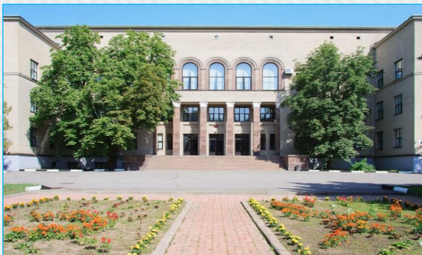
Главный корпус АО «НИМИ им. В.В. Бахирева»
